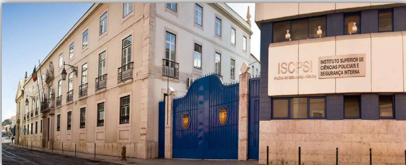
Figura 1: Fachada principal do ISCPsi.
